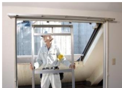
1. 既存サッシの取外し
