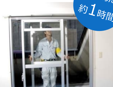
3. 新しいサッシの取付
