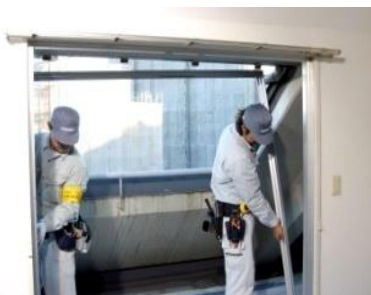
2. 新規枠の取付
