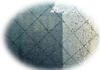
結露が発生する
